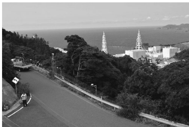
島根原子力発電所
